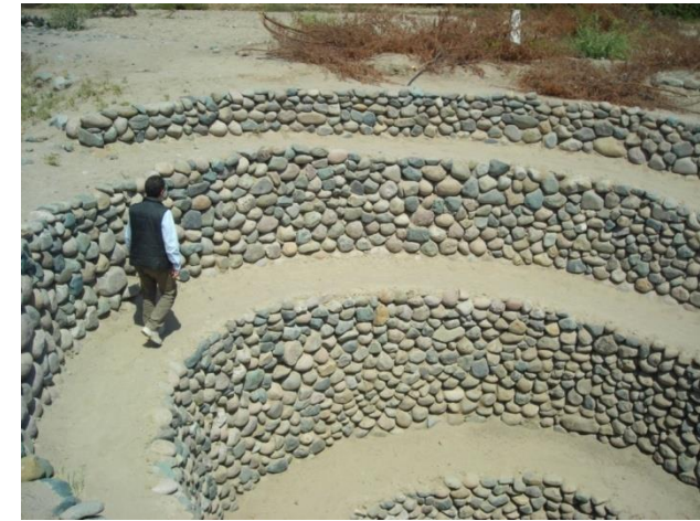
Puquio de Cantallos : detail of circular chimney
